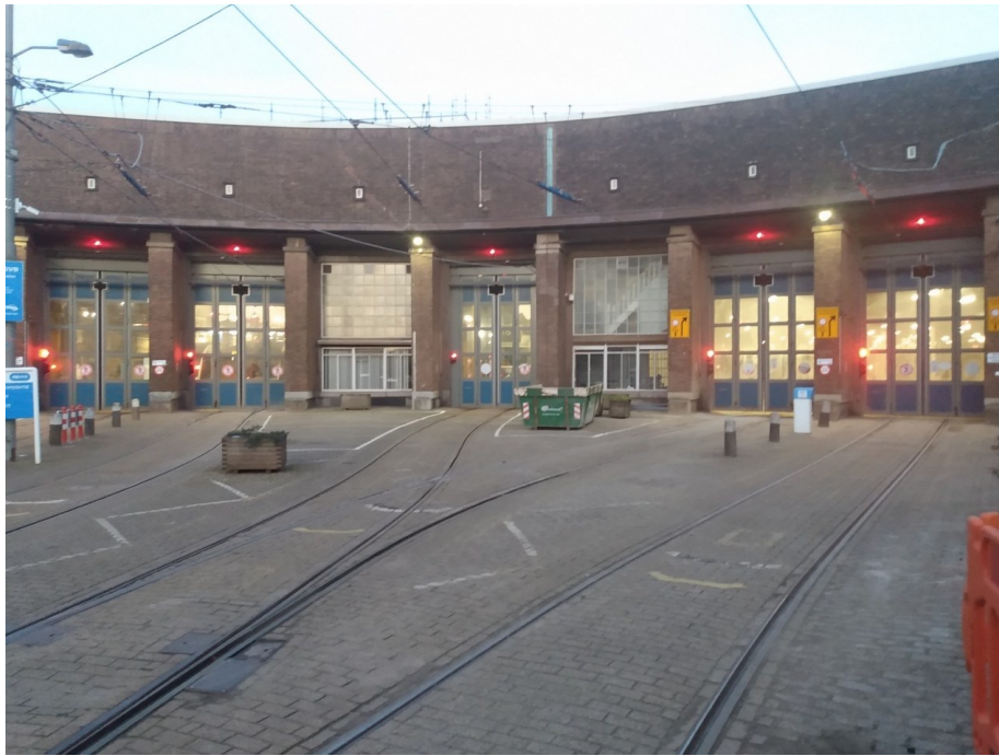
Ingang van de tramremise aan de Lekstraat. De Kromme-Mijdrechtstraat grenst aan de oneven zijde aan deze remise met de nummers 31 tot en met 99.
