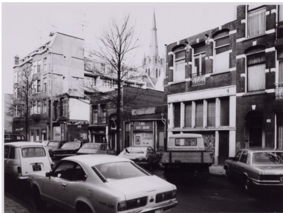
Bovenste etages werden in de jaren zeventig vorige eeuw al bij voorbaat gesloopt om de druk op de fundamenteën te verlagen. Op de achtergrond de in de jaren tachtig gesloopte Bonifatiuskerk aan het Kastanjeplein.
