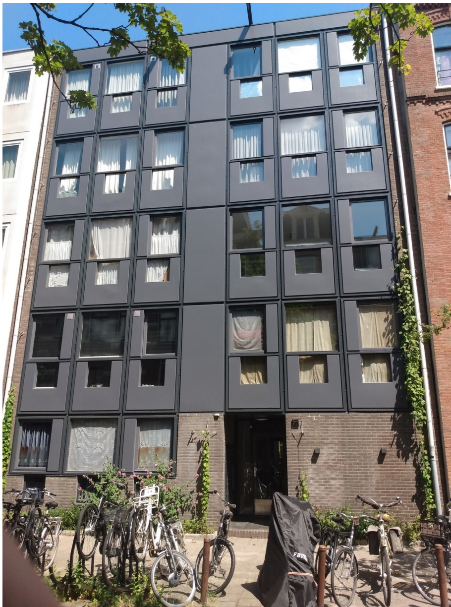
Het pand met de 14 HAT-eenheden, Swammerdamstraat 29. Nummer 29-H is een hoog rechts, met de slordig dichtgetrokken gordijnen. De woning telt slechts één kamer en kent alleen een voor, geen achter. De woningen staan ruggelings tegen elkaar. Doorluchten is er niet bij.
