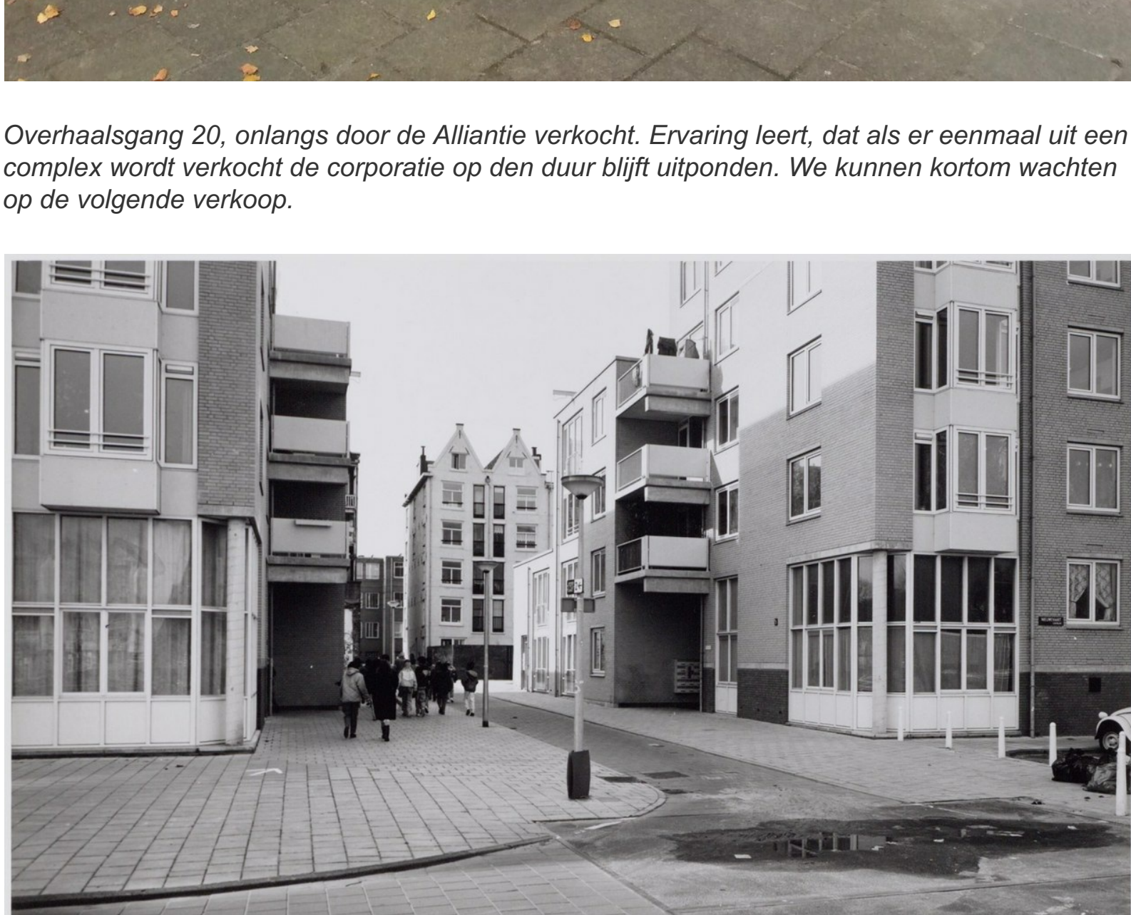
Overhaalsgang 20, onlangs door de Alliantie verkocht. Ervaring leert, dat als er eenmaal uit een complex wordt verkocht de corporatie op den duur blijft uitponden. We kunnen kortom wachten op de volgende verkoop.
