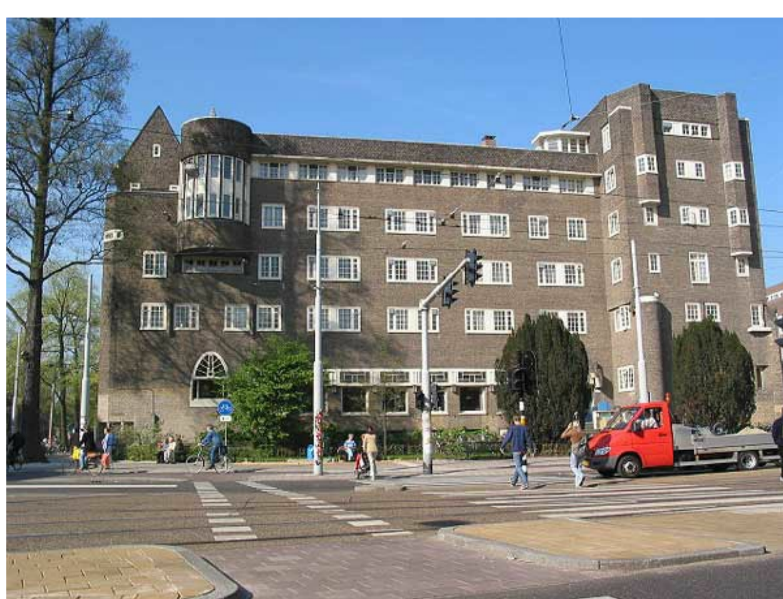
Het fraaie Lydia-gebouw waar het Buurthuis is gevestigd
