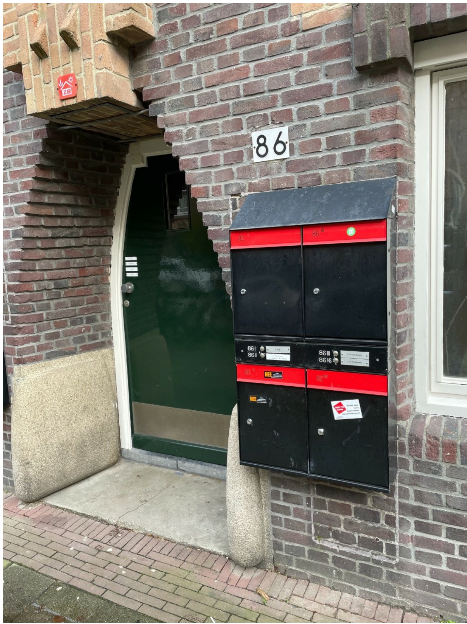
De portiek. Wat een bakstenenspel!
