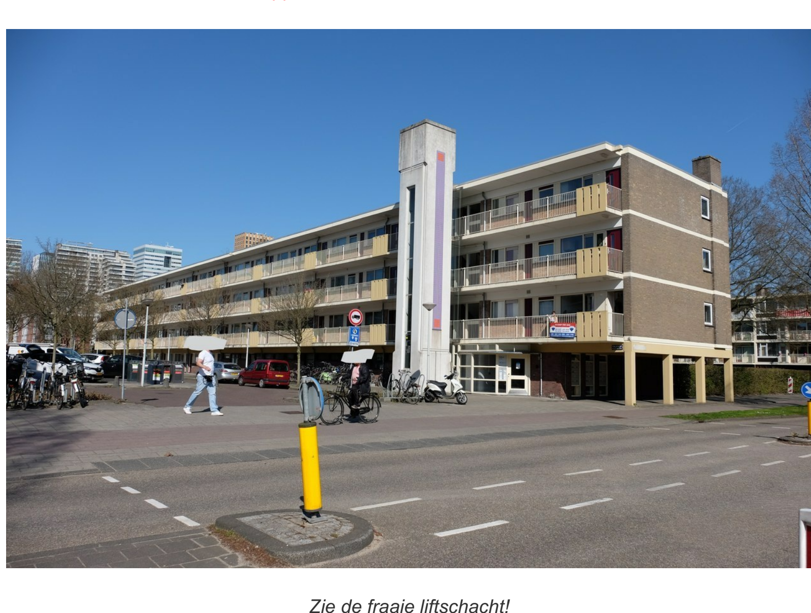
Zie de fraaie liftschacht!
