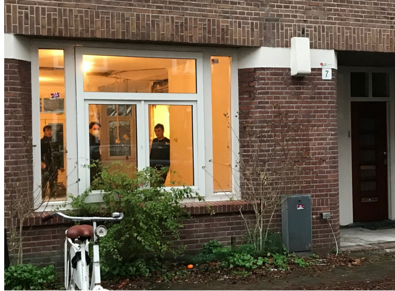
Oude-IJsselstraat 7, onlangs door de Alliantie verkocht, was een woning, geknipt voor een invalide persoon. Verhoogde stoep, scootmobiel aansluiting, drempelloos. Te zien is dat een aanbouw aan de achterkant, de tuin in, in de maak is.
