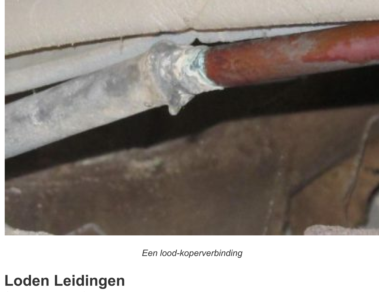
Een lood-koperverbinding
