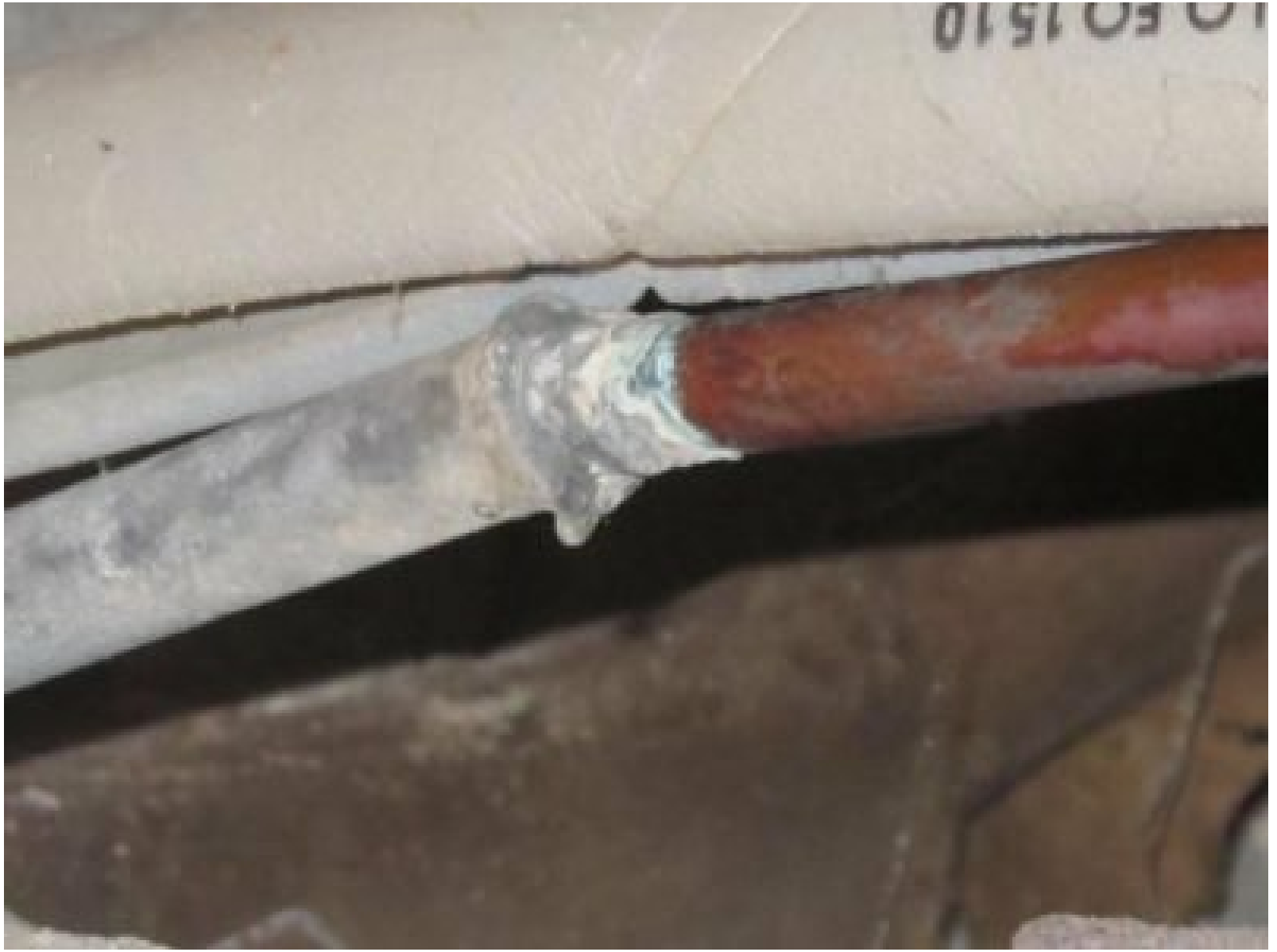
Een koper-loodverbinding
