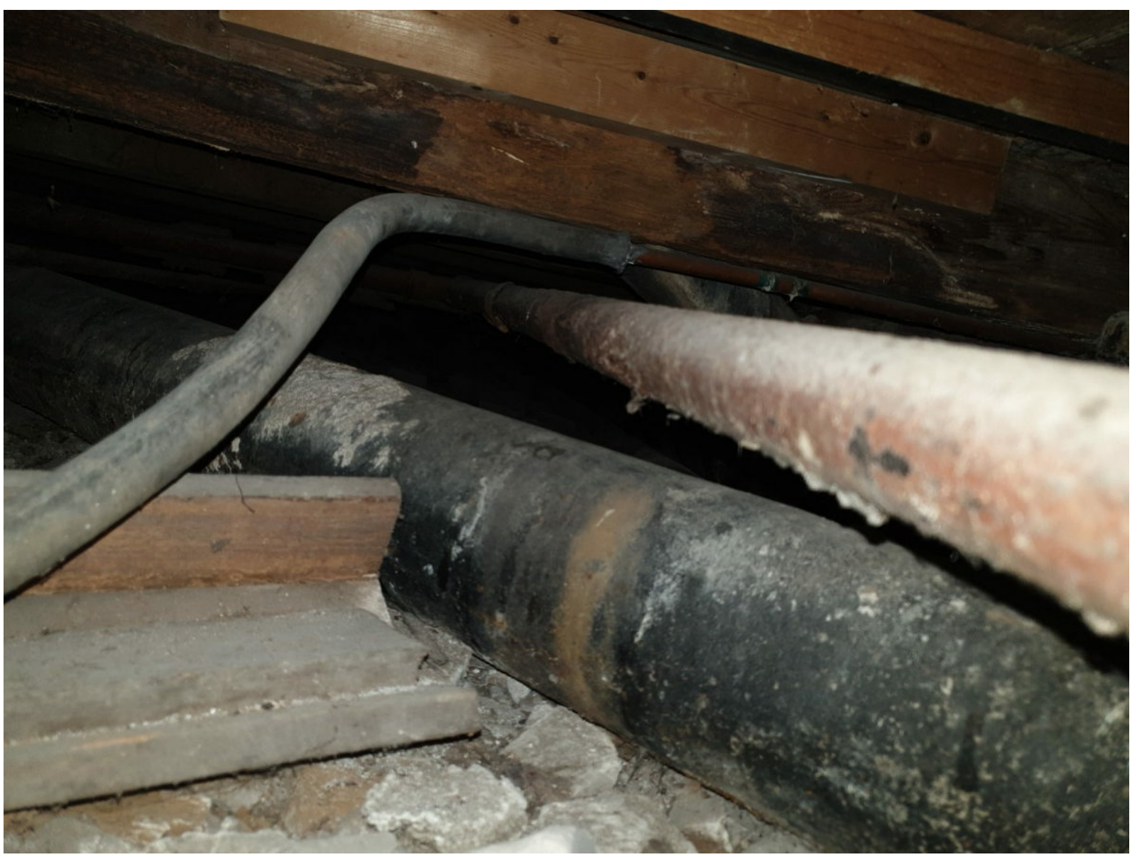
Een loden waterleiding in de kruipruimte van een Zuid-woning
